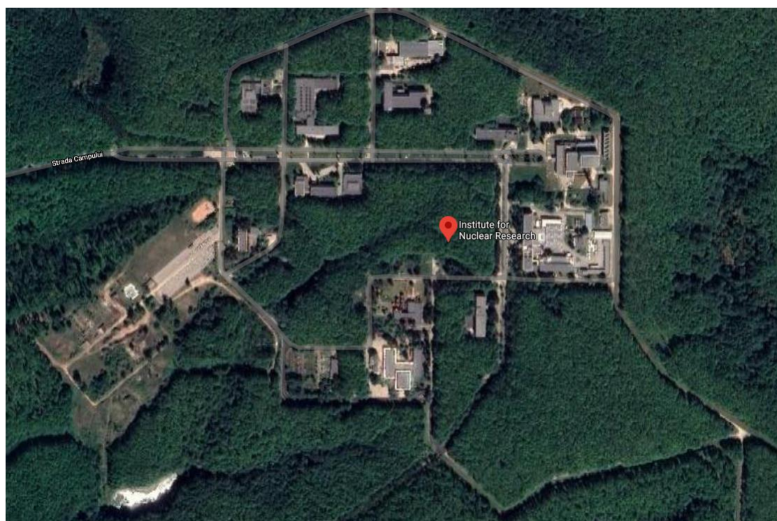
Fig. 5.1 Platforma nucleara Mioveni, asezarea cladirilor, vedere aeriana
